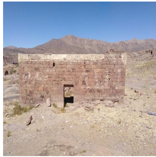
الشكل ٢٧: الواجهة الجنوبية للمسجد الشرقي للحصن.
